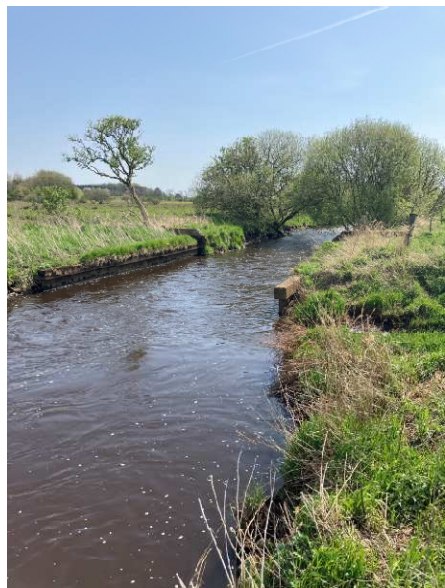
Figur 3-9 Stenstryg ved gammelt betonstyrt i st. 2.350 m ved Herningsholm Å
